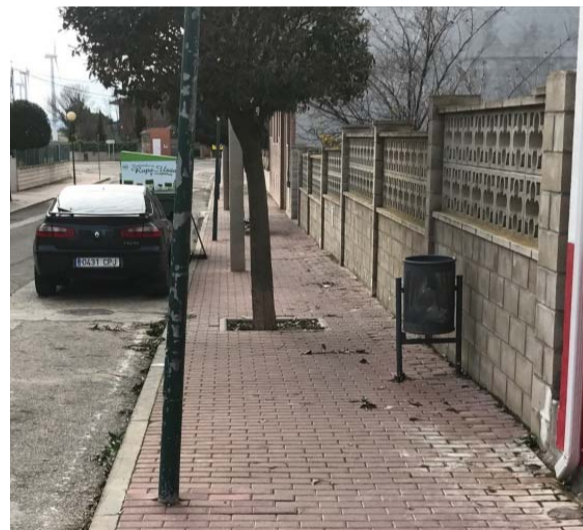
Mobiliario urbano cortando el itinerario
