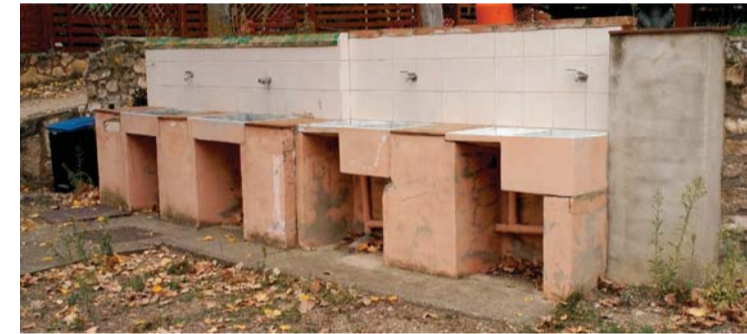
Conjuntos fregaderos y lavaderos sin cubrición
